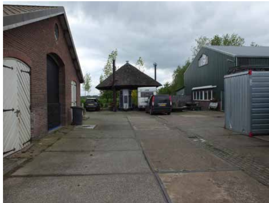
Achterzijde stal met hooiberg en loods
