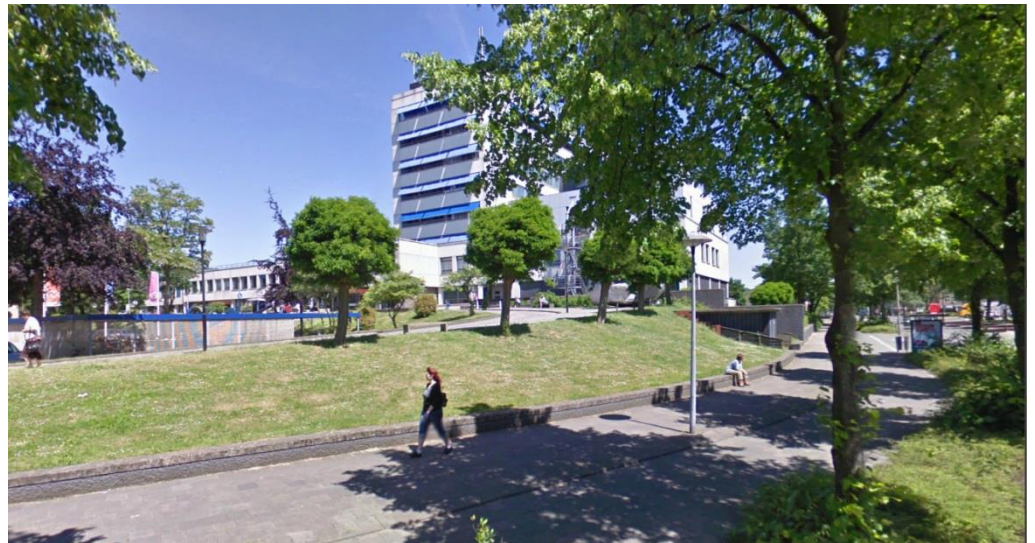
Nieuwe en bestaande rand in dezelfde afwerking.
