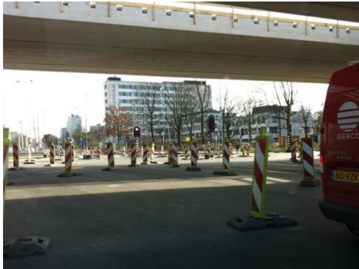
De fly-over biedt goed zicht van de ene zijde naar de andere zijde van het plein.
