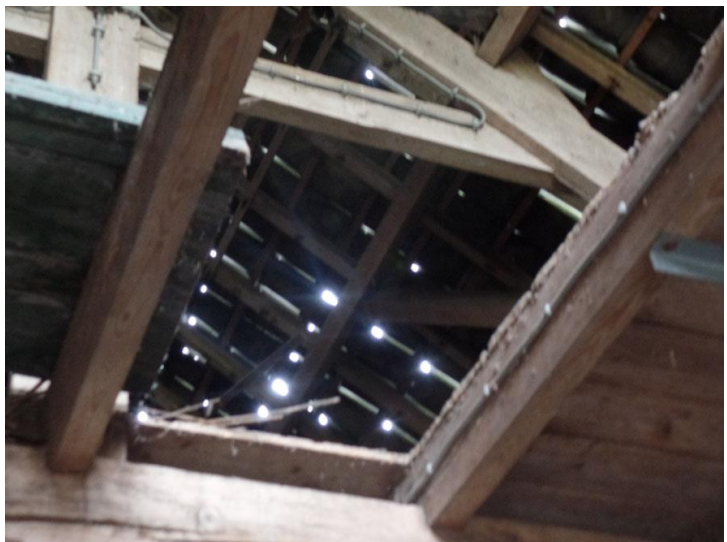
Figuur 7: Binnenzijde van een deel van het staldak
