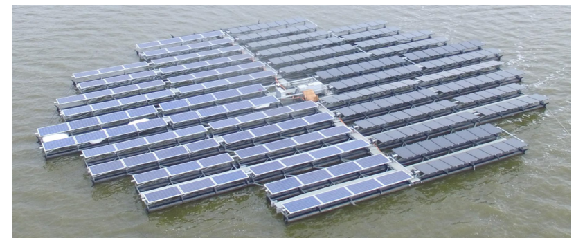
Afbeelding 7. Voorbeeld roterend drijvend zonne-energiesysteem.
