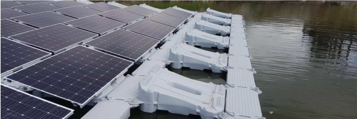
Afbeelding 2. Voorbeeld drijvende zonnepanelen op plastic (HDPE) drijvers. Bron: www.solarfloating.eu
