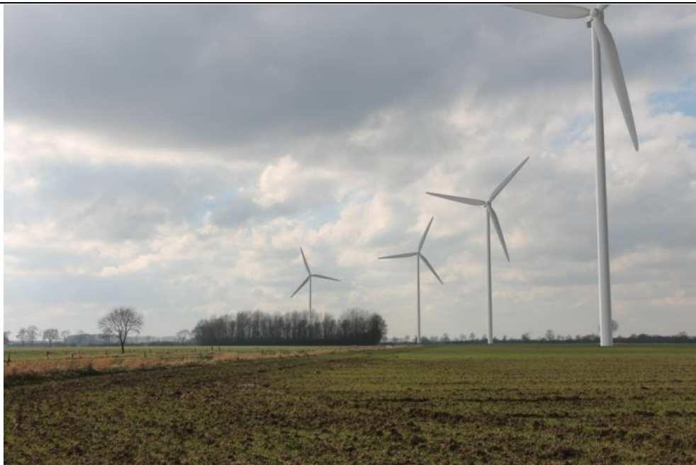
Figuur 15 Windpark op een afstand van 5 keer de tiphoogte; de windturbines zijn beeldbepalend en zeer dominant aanwezig.
