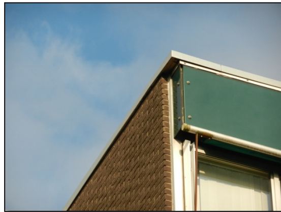
Figuur 5. Metalen dakranden aan het pand.
