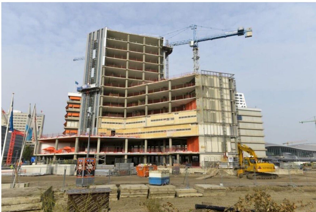
Gezicht op de Luitenant-Generaal Knoopkazerne (Mineurslaan 500) te Utrecht die wordt omgebouwd tot Rijksgebouw de Knoop, vanuit zuidelijke richting. Ontgravingen hebben rondom plaatsgevonden om de funderingen van het gebouw bloot te leggen. Meest rechts op de foto een gedeelte van het in te richten parkeerterrein, dat tot op het zelfde niveau is ontgraven. Foto genomen op 26-10-2016 (Bron: https://hetutrechtsarchief.nl/ ).
