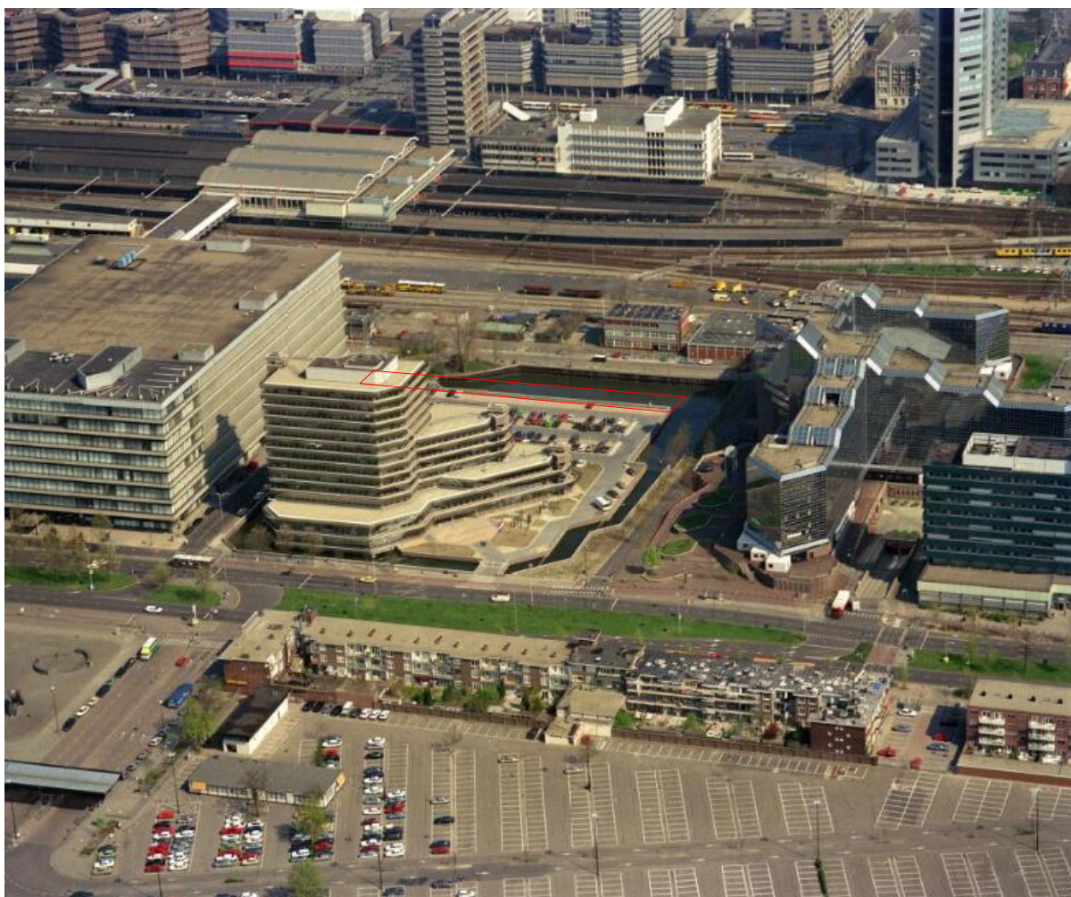
Luchtfoto van het Rijkskantoor De Knoop (Mineurslaan 500/Croeselaan 14) met in het midden de Croeselaan en links het Beatrixgebouw van de Jaarbeurs (Jaarbeursplein 6) en rechts het Hoofdkantoor Rabobank Nederland (Croeselaan 18), foto genomen in maart 1990. Het merendeel van het plangebied (rode belijning) ligt ter hoogte van het gedeelte water (Bron: https://hetutrechtsarchief.nl/ ).
