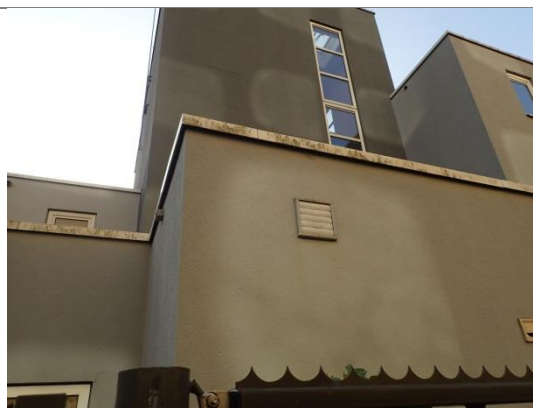
Foto 6: Het te slopen gebouw is toegankelijk voor vleermuizen via de daktrimmen.
