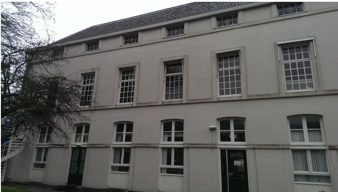
Figuur 4 Gebouw L, achterzijde Lange Nieuwstraat
