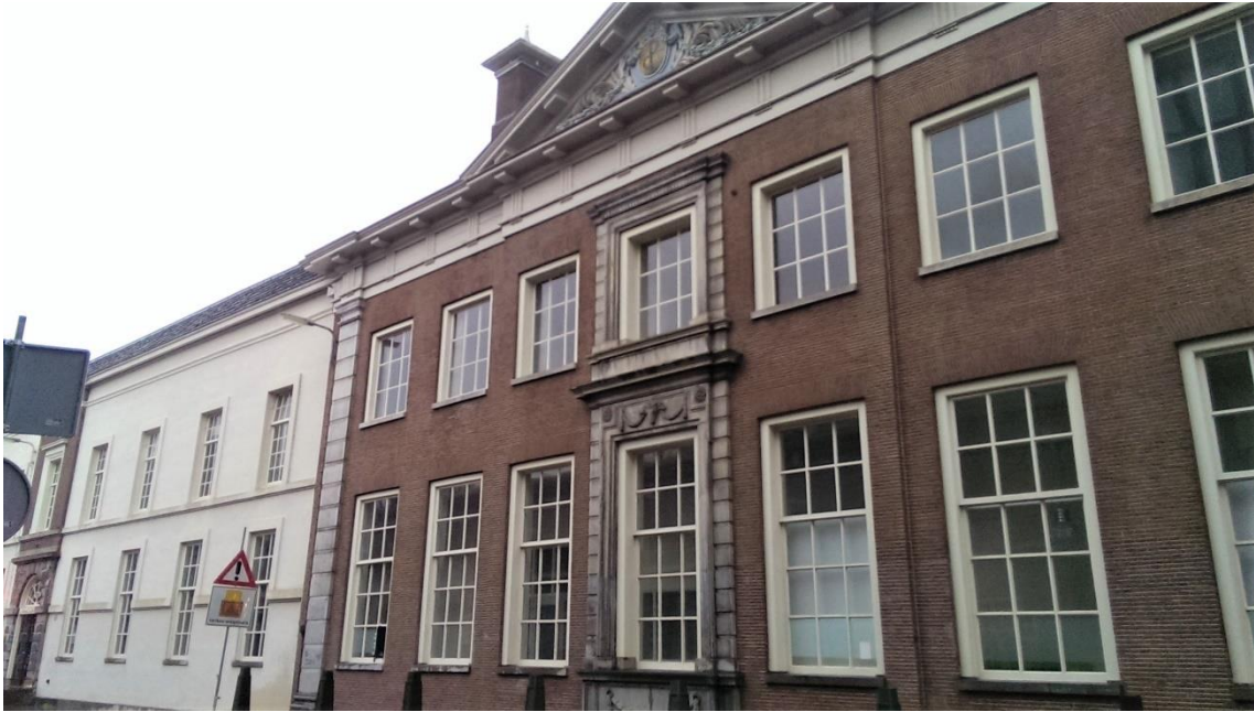
Figuur 3 Gebouw L, voorzijde aan de Lange Nieuwstraat
