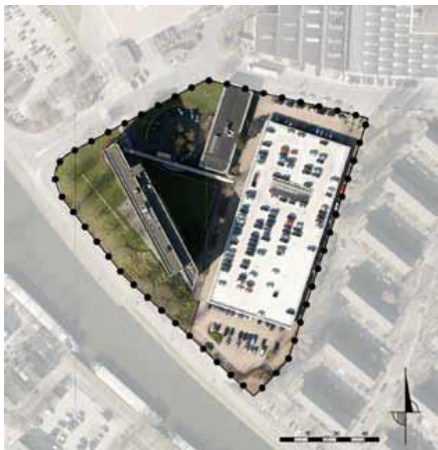
Luchtfoto plangebied ( Bouwenvelop Vleutensevaart 100 )
