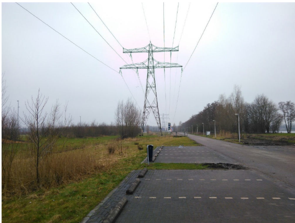
Foto 3: overzicht, vanaf busbaan, richting manege / masten 9, 10 en 11
