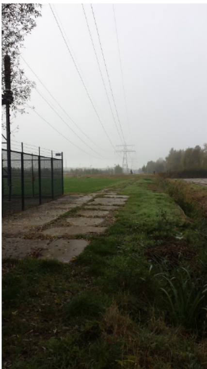
Foto 2: vanaf mast 8, richting de busbaan en masten 9, 10 en 11
