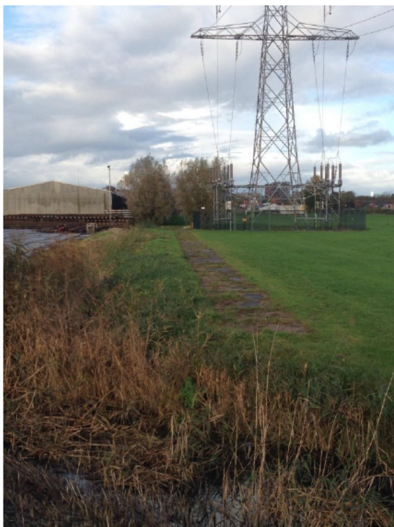
Foto 1: overzicht, vanaf busbaan, richting mast 8
