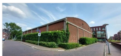
Figuur 2.6 Achterzijde onderzoekslocatie gezien vanuit het westen.
