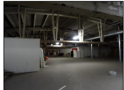
Figuur 5. Zolder onderzoekslocatie.
