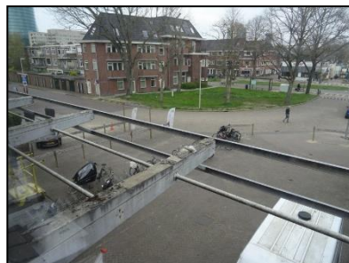
Figuur 7. Verharding aan oostzijde onderzoekslocatie.
