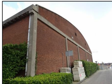
Figuur 4. Achterzijde onderzoekslocatie.
