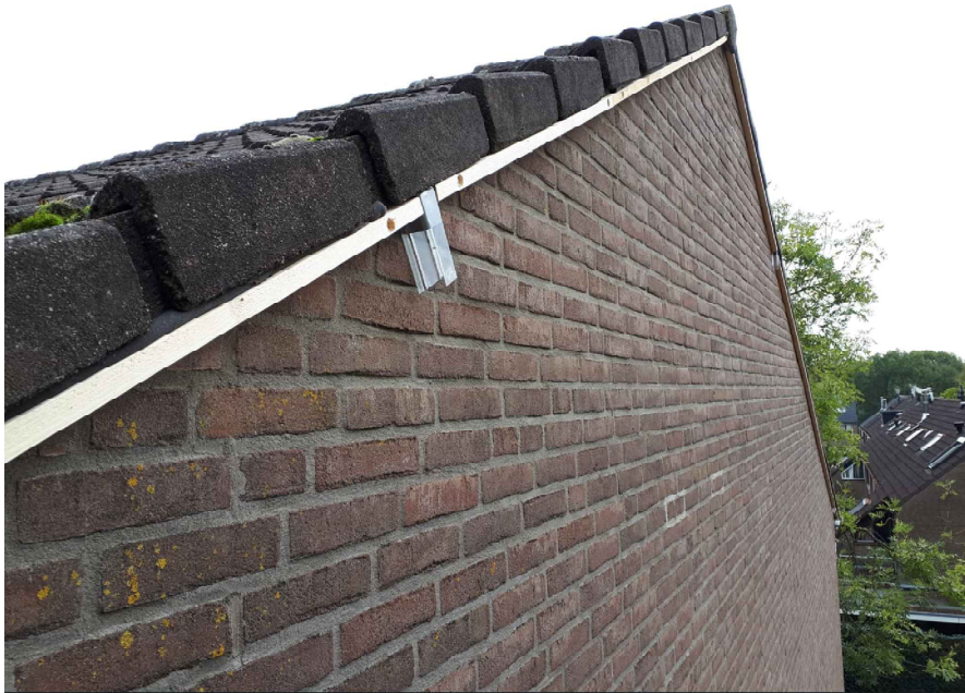
Detail exclusion flaps met panlatten en rugvulling van kit
