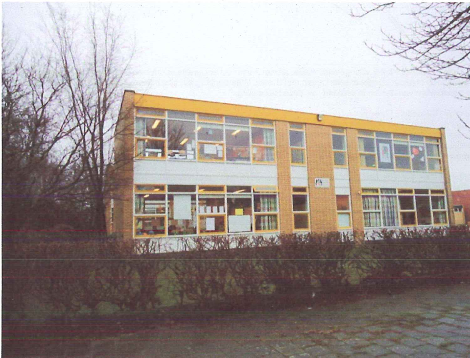
Foto van het hoofdgebouw van de OBS Overvecht. Het gebouw biedt vleermuizen potentiële verblijfplaatsen.
