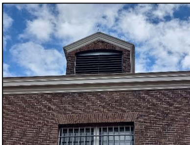
Figuur 2.4. Ontluchtingsrooster aan de oostzijde van het voorgebouw.
