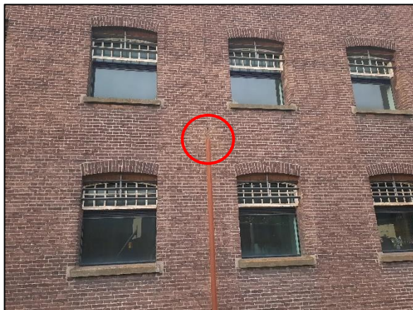
Figuur 5.5 Aangetroffen zomerverblijfplaats in de bebouwing op de onderzoekslocatie (rood omcirkeld).
