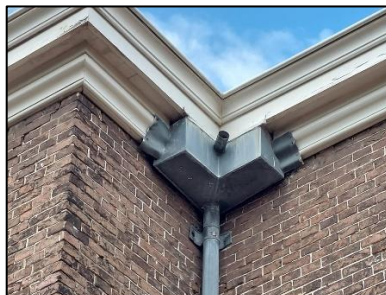
Figuur 2.5. Witte boording en regenpijp met loodkappen verschaft ruimte tussen muur.
