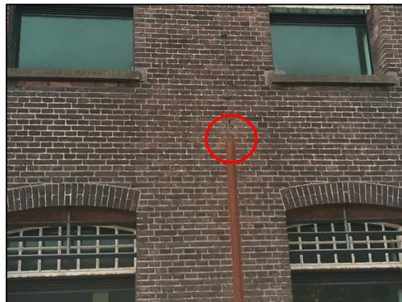
Figuur 5.6 Aangetroffen zomerverblijfplaats in de bebouwing op de onderzoekslocatie (rood omcirkeld).
