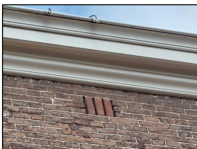
Figuur 6. Ontluchtingsgaten in de muren van het gebouw.
