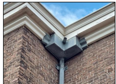
Figuur 5. Witte boording en regenpijp met loodkappen verschaft ruimte tussen muur.
