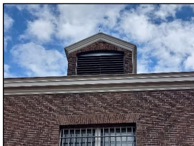
Figuur 4. Ontluchtingsrooster aan de oostzijde van het voorgebouw.
