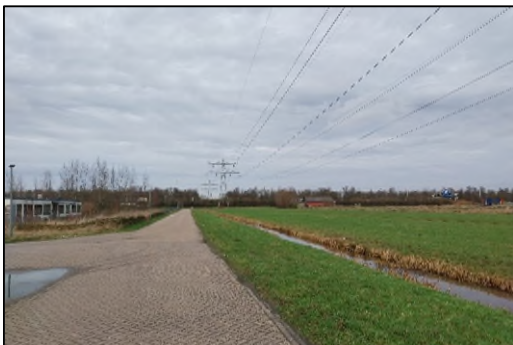
Figuur 2.5. Inrit naar het station en mast 12.
