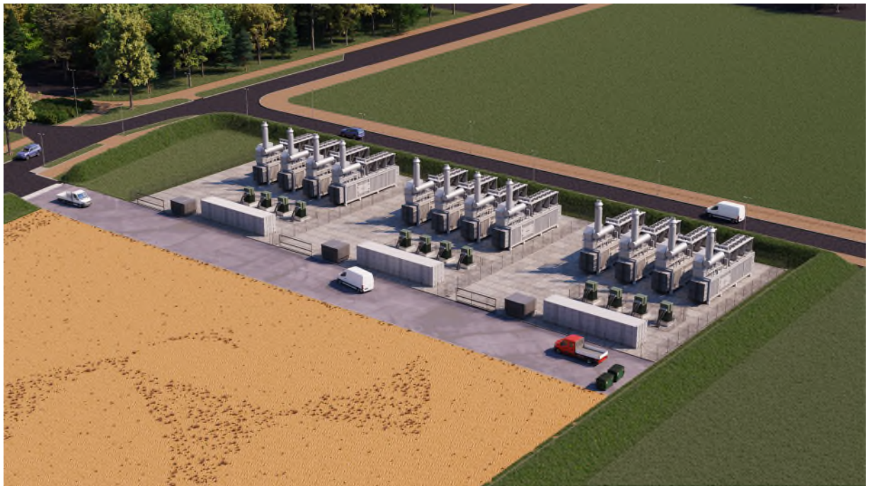
Figuur 4: Illustratief voorbeeld van de stroomgeneratoren op Strijkviertel (bron: Stedin Netbeheer)
