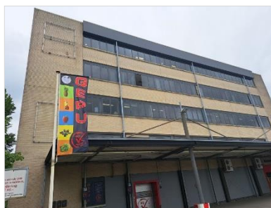
Figuur 2.4 Bebouwing op de noord-zijde.
