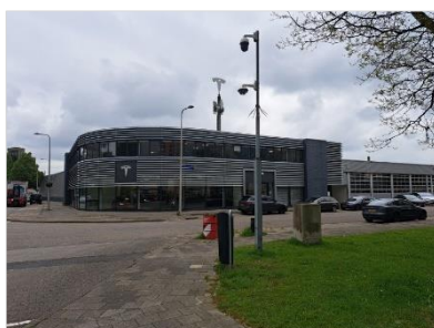
Figuur 2.13 Kantoorgebouw en garage in het centrum van het terrein.
