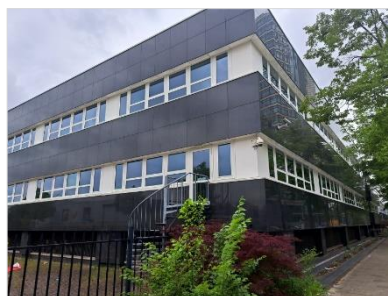
Figuur 2.3 Bebouwing op de noord-zijde.
