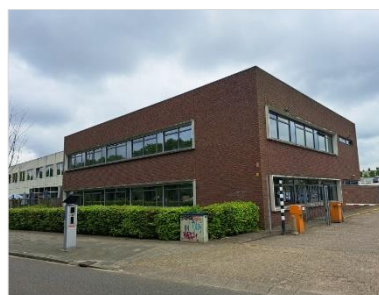
Figuur 2.11 Kantoorgebouw in het midden van de onderzoekslocatie.
