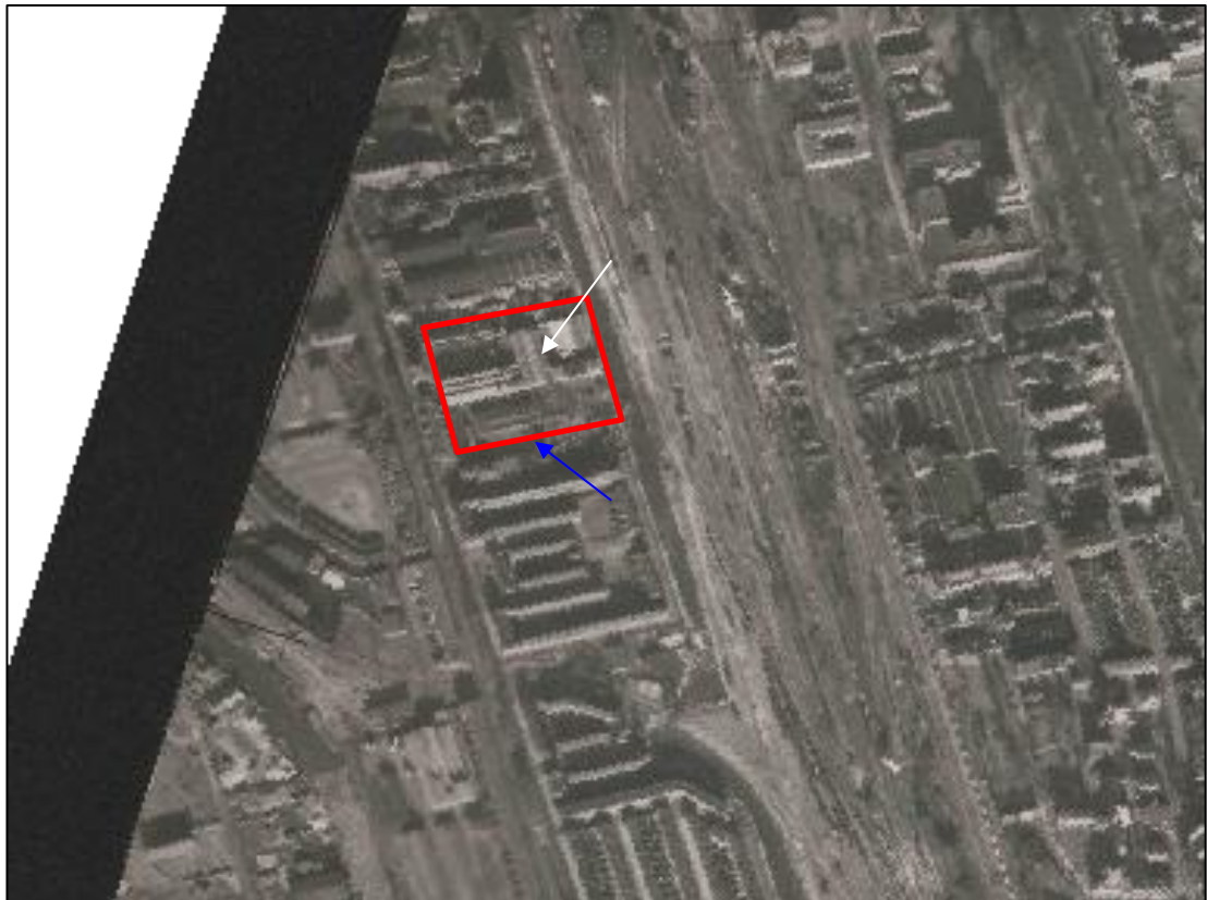
Afbeelding 25: Luchtfoto van de Royal Air Force uit 1945 (vlucht 225, run 03, foto 4028) met het plangebied in het rode kader ( https://library.wur.nl/WebQuery/geoportal/raf ). Bij de witte pijl ligt de bebouwing van Firma J. Pintsch / MEAF en bij de blauwe pijl (deels buiten plangebied) de bebouwing van PUEM / REMU.
