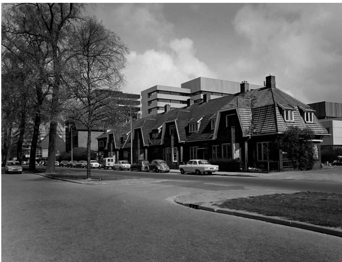
Afbeelding 26: Foto van de in 1972 gesloopte dienstwoningen van REMU langs de Croeselaan (Croeselaan 32-42, direct ten zuidwesten van het plangebied), met centraal op de achtergrond het nieuw gebouwde hoofdkantoor van REMU in het noordwesten van het plangebied (huidige gebouw 'Zilver', Croeselaan 28) en rechtsachter het laboratoriumgebouw / C.M.A. gebouw. Bron: https://hetutrechtsarchief.nl/ .
