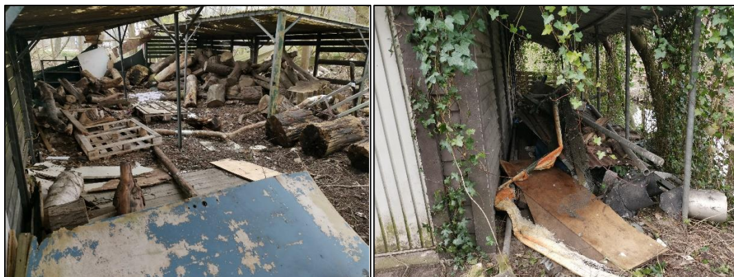
Figuur 2.2 (links): Impressie van één van de overkappingen, onder deze overkapping liggen boomstammen en ander houtmateriaal; Figuur 2.3 (rechts): Bouwmaterialen onder de andere overkapping, deze staat tegen een bijgebouwtje aangebouwd.
