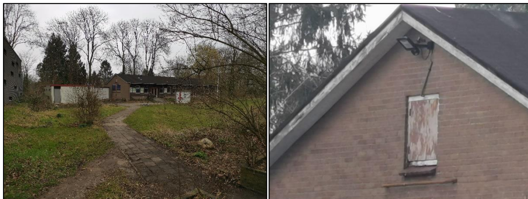
Figuur 2.3 (links): Impressie van het scoutinggebouw vanaf de entree gezien; Figuur 2.4 (rechts): Impressie van de daklijst, vanaf de westelijke zijde gezien. Deze vertoont geen kieren of holten.
