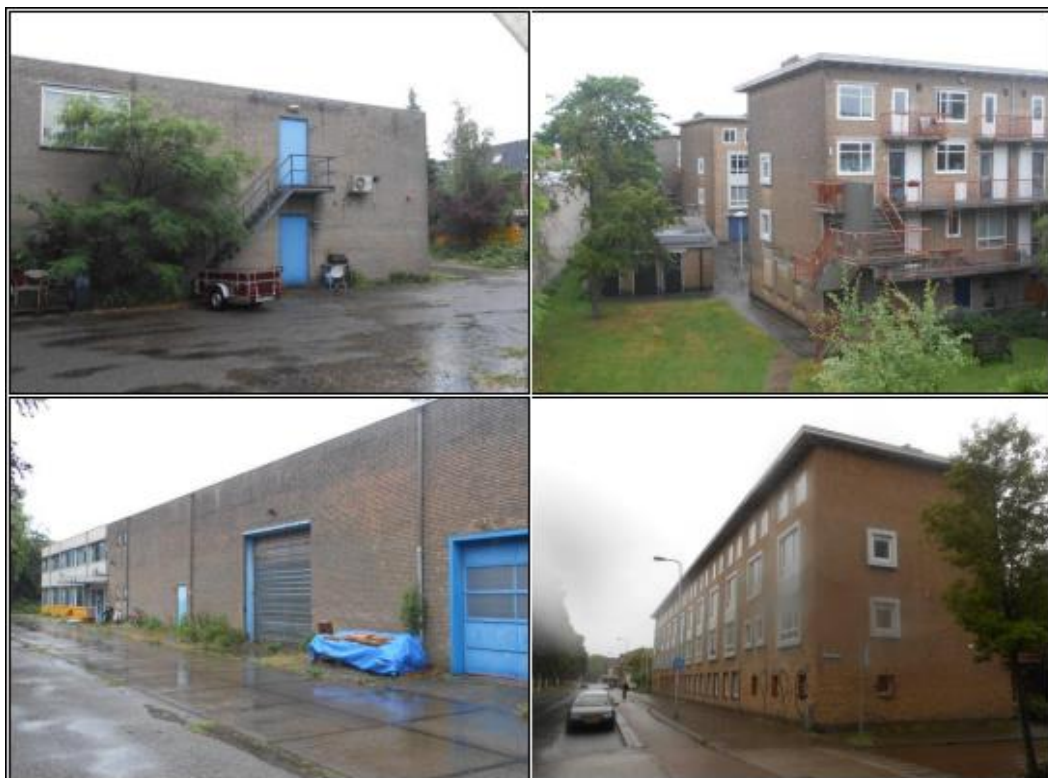
Afbeelding 2: Indruk van het plangebied, van linksboven naar rechtsonder: westzijde bedrijfsgebouw, portiekflats en een groenstrook, zuidzijde bedrijfsgebouw, straatzijde (Jutfaseweg) portiekflat (foto's: Aveco de Bondt, 2017).
