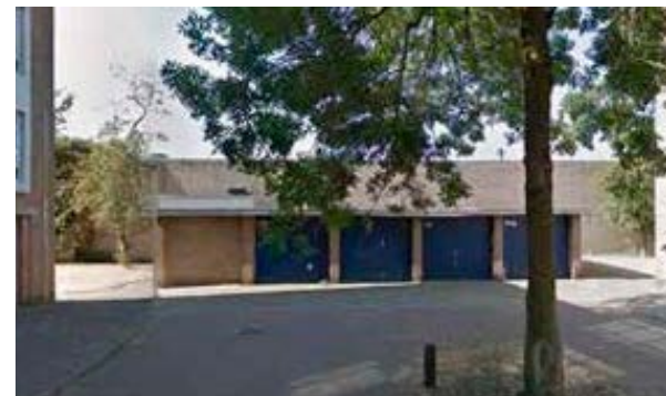
Afbeelding 9: Aanzicht garageboxen en elektriciteitsgebouw Stedin vanaf de Reitdiepstraat
