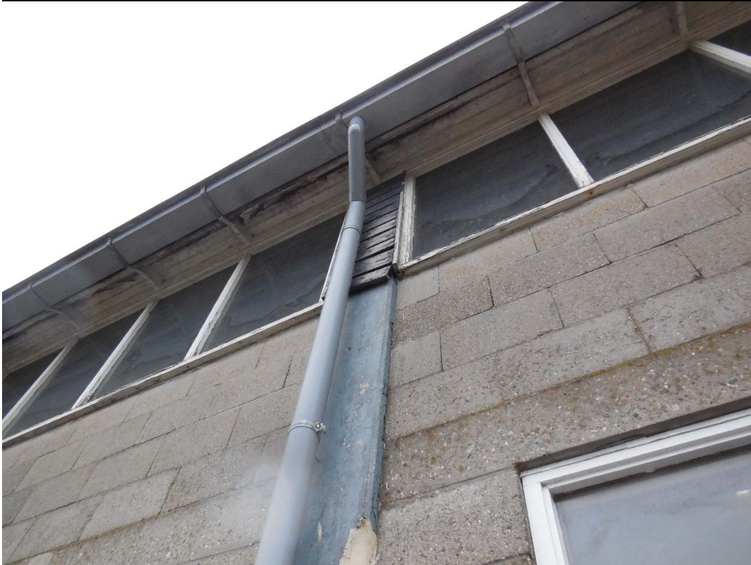
Figuur 2.4 Achter de betimmering achter de regenpijp kunnen vleermuizen verblijven. Mogelijk kunnen ze via deze openingen ook in de spouw komen.
