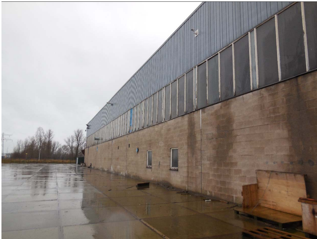
Figuur 1.4 De oostzijde van het meest zuidelijk gelegen gebouw.
