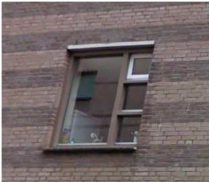
Figuur I.7 Raam in appartement aan Sint Jacobsstraat
