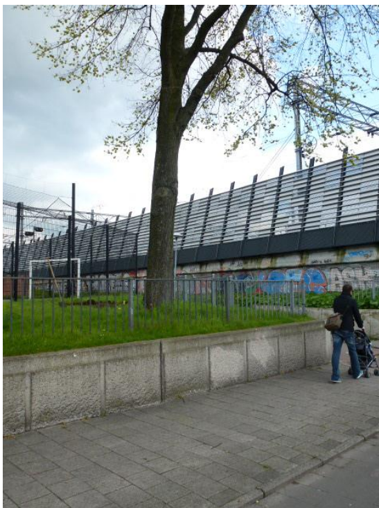
Foto 4, De rijweg en trottoir liggen 1 meter lager.
