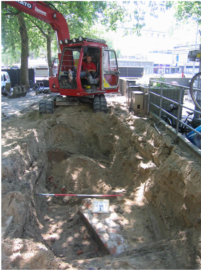
Afbeelding 2 De keermuur in sleuf 12 in 2006.
