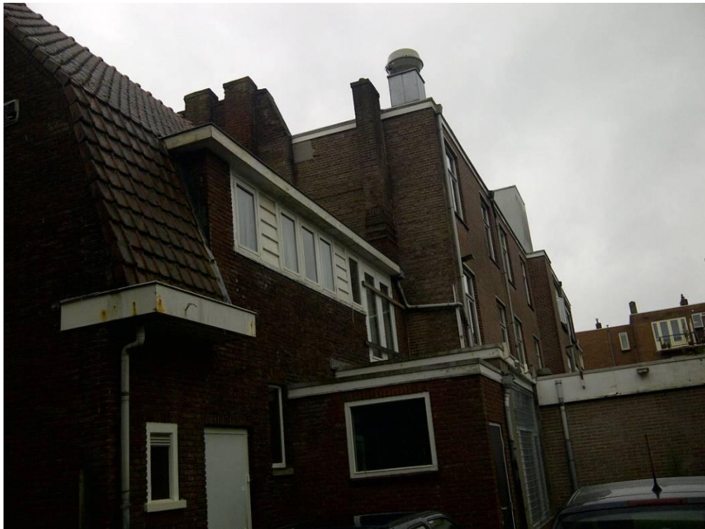
Foto 3 achterzijde van het voormalige woonhuis
