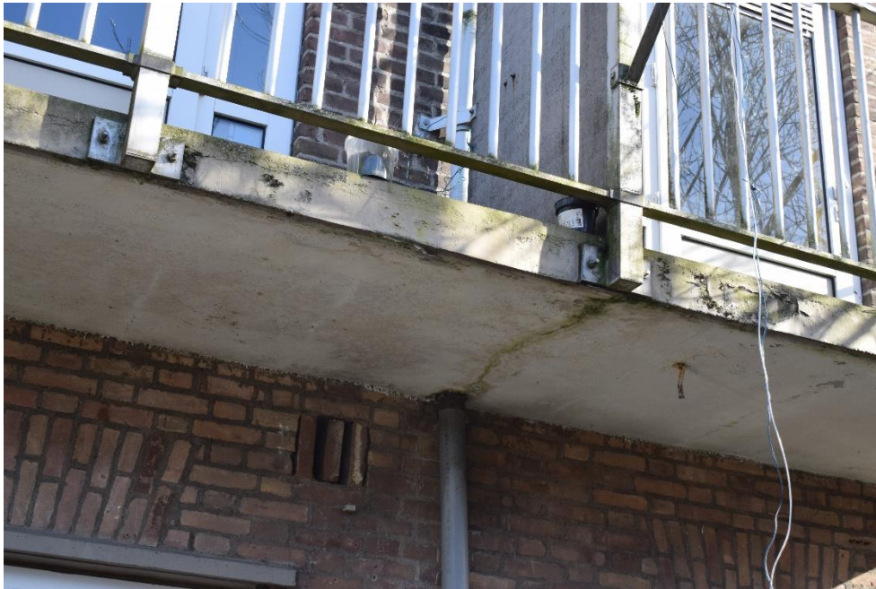
5 Toegankelijke spouwmuren door ventilatieroosters en open stootvoegen
