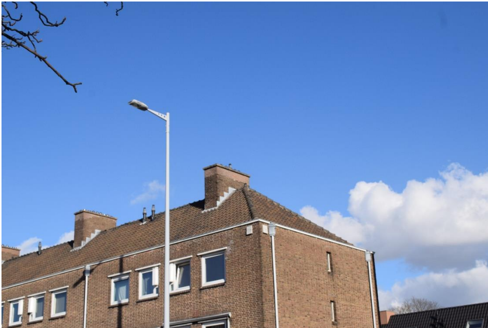
1 Gebouwen met betonnen dakrand en pangedekt en deels open schoorstenen
