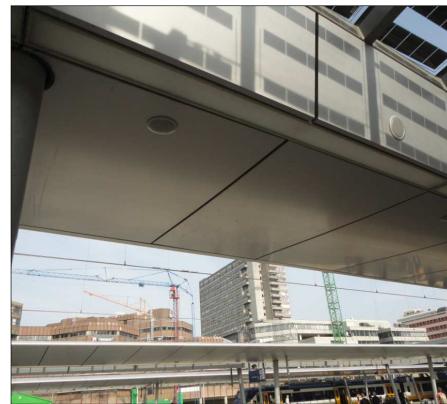
Foto 1 en 2: ronde speakers in de nieuwe perronkappen (weergegeven perron aan sporen 5/7)
