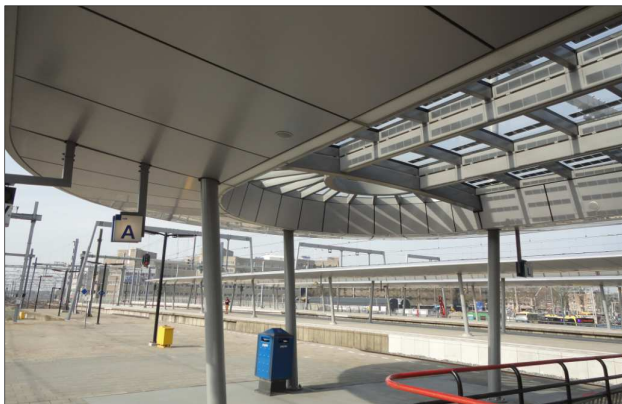
Foto 1 en 2: ronde speakers in de nieuwe perronkappen (weergegeven perron aan sporen 5/7)
