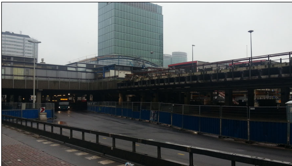
Foto: busbaan (situatie november 2013)
