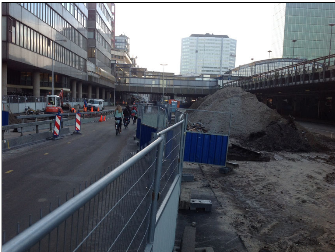
Foto: werkzaamheden (situatie november 2013)
