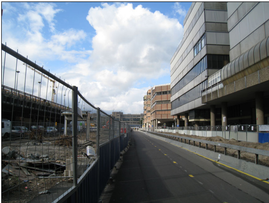
Foto: werkzaamheden (situatie september 2013)
