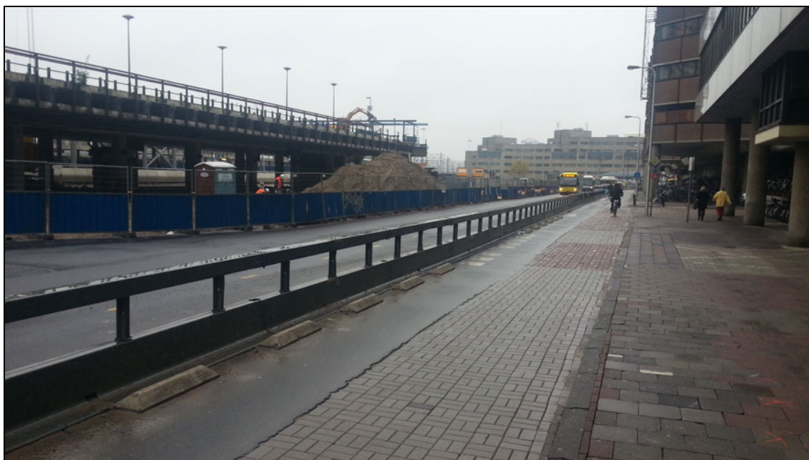
Foto: busbaan (situatie november 2013)
