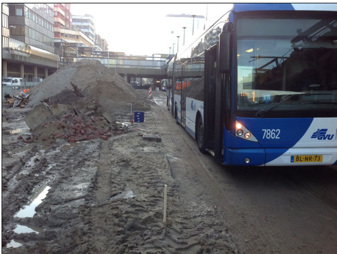
Foto: werkzaamheden (situatie november 2013)
