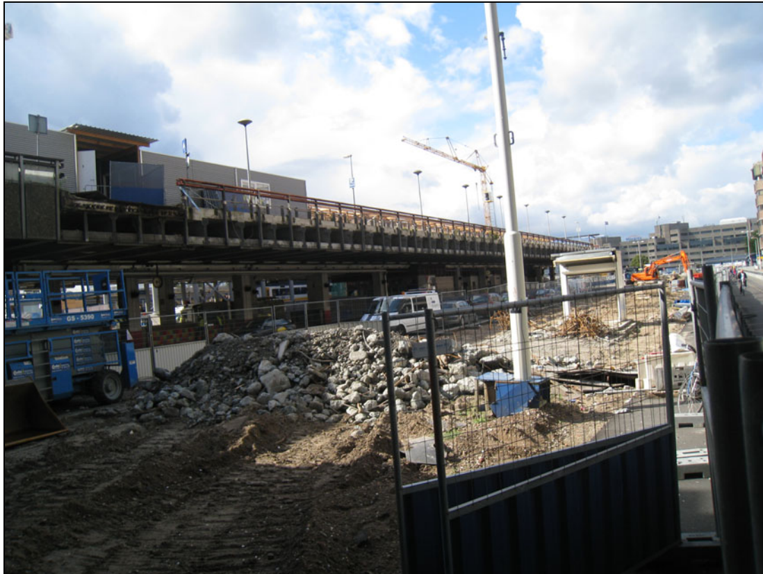
Foto: sloopactiviteiten taxiplatform (situatie september 2013)
