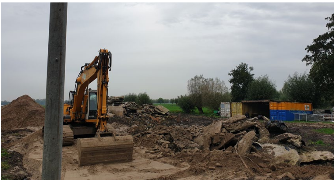
Huidige beeld op het plangebied vanaf de Nedereindseweg, na sloop van opstallen.
