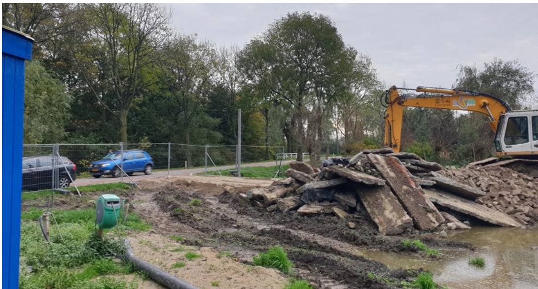
Huidig beeld vanuit het plangebied naar de Nedereindseweg, na sloop van opstallen.
