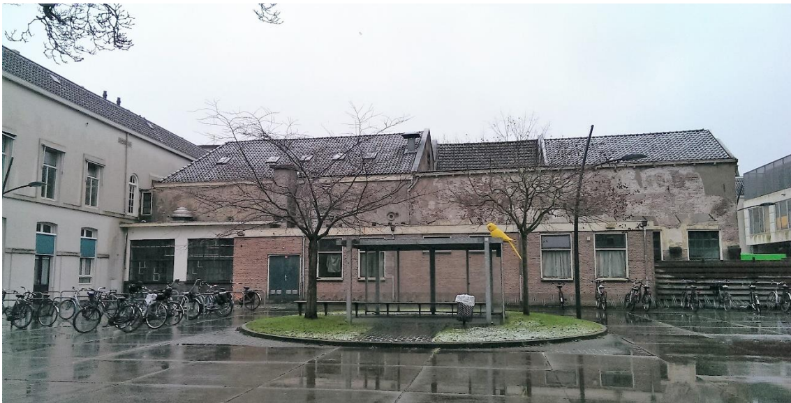
Figuur 5 Achterzijde Lange Nieuwstraat, deelgebied Museumhotel, met zicht op te slopen gebouw R
