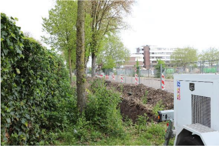
Figuur 10. Graafwerkzaamheden die al worden uitgevoerd.
