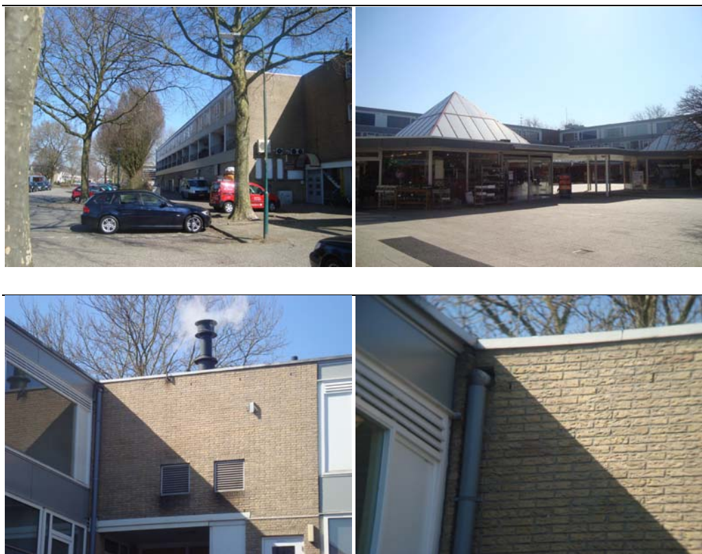
Figuur 2.2 De foto links boven toont de buitenkant van het winkelcentrum. De foto rechts boven toont het binnenplein met de twee centraal gelegen gebouwen. De onderste twee foto's geven een beeld van de aanwezige stenen muren met stootvoegen en de openingen die bij het uitkomen van een regenpijp aanwezig is. Via de stootvoegen kunnen vleermuizen in de spouw komen. Een opening bij een regenpijp kan door huismus, gierzwaluw of algemene broedvogel als nestlocatie gebruikt worden
