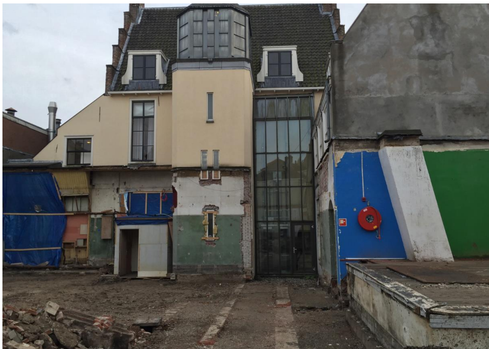
Figuur 2.5 Oorspronkelijke aanbouw is gesloopt (zicht op de sociëteit)
