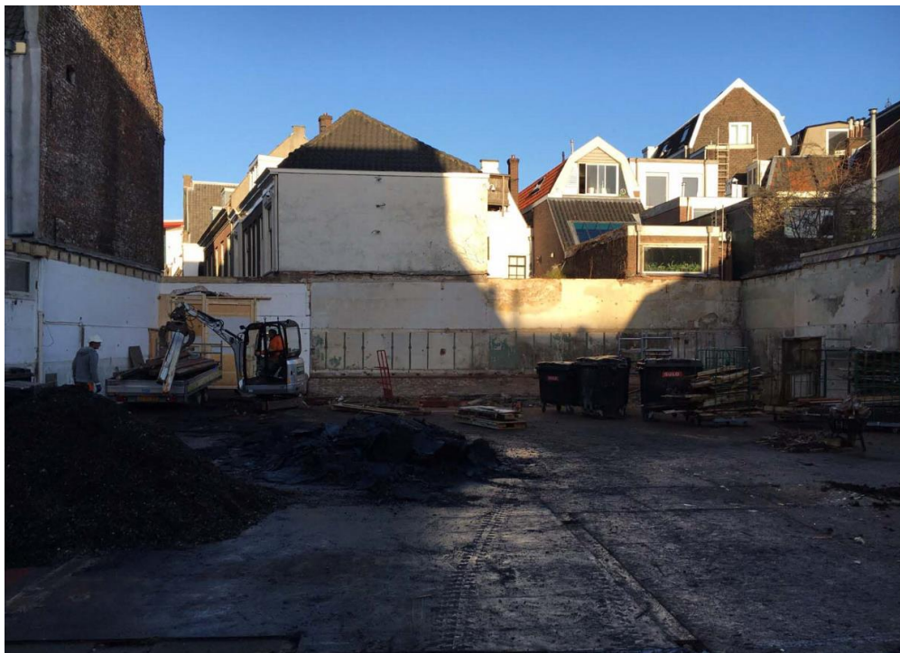
Figuur 2.4 Oorspronkelijke aanbouw is gesloopt (zicht vanuit de sociëteit)
