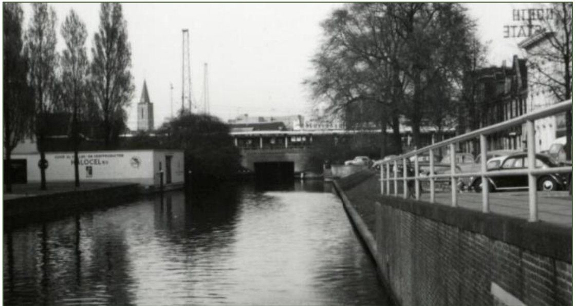
De Leidsche Rijn met tunnel onders het spoor en rechts de Leidseweg (nu de Van Sijpesteijnkade) tussen 1960 en 1965. 53
