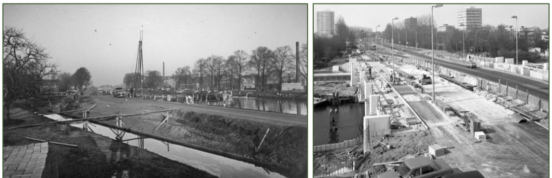
Links bouw Paul Krugerbrug in 1941 en rechts werkzaamheden aan de toen geheten Paul Krugerbrug in 1983. 40
