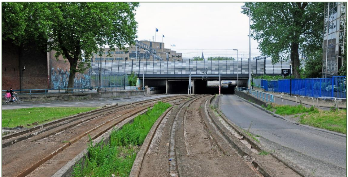
Gezicht in de Leidseveertunnel te Utrecht in 2013, vanaf het Westplein. 59
