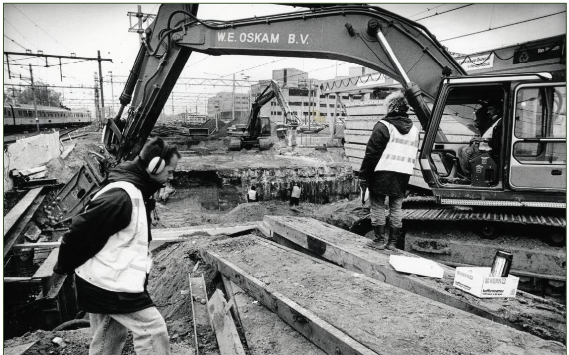
Afbeelding van de werkzaamheden t.b.v. de verbouwing van de Van Sijpesteijntunnel aan de noordzijde van het station. 55
