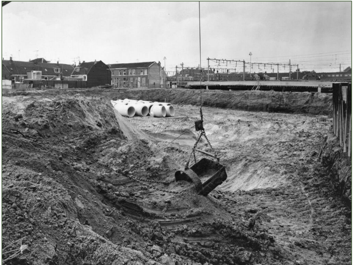
Afbeelding uit 1967 van het graven van de bouwput voor de toekomstige Daalsetunnel te Utrecht, uit het zuiden, met links op de achtergrond de Kolfstraat en de achterzijdes van enkele huizen aan de Kruitstraat. 60
