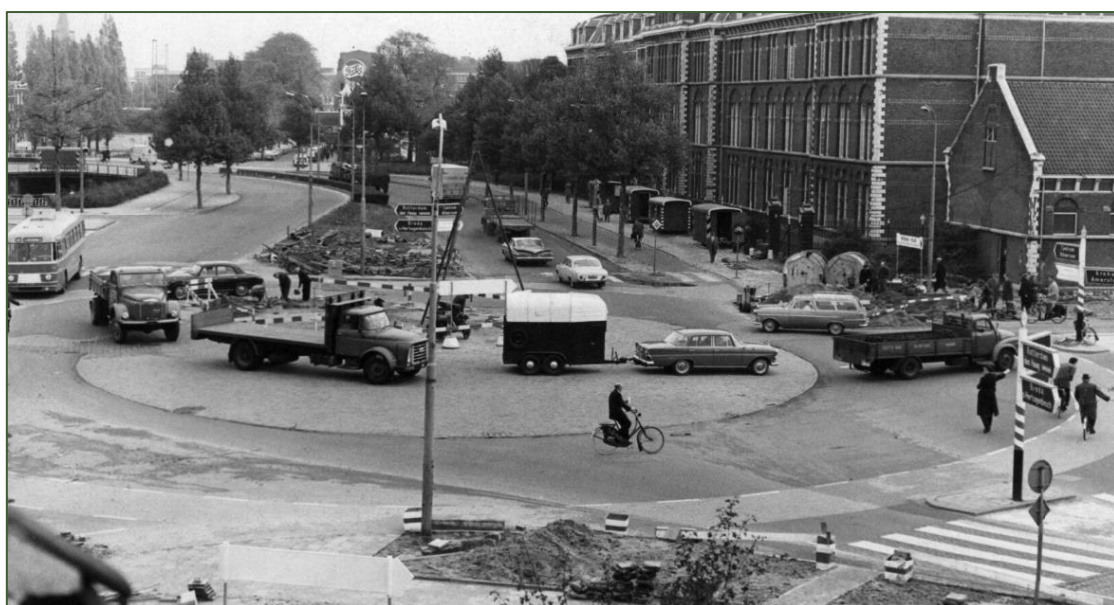
Gezicht op de reconstructie van de kruising van de Croeselaan (rechts), Leidseweg en Graadt van Roggenweg (voorgond); op de achtergrond de Van Sypesteynkazerne (Leidseweg 22). N.B.: De rotonde heeft op 25 juni 1968 de naam Westplein gekregen. Op 8 mei 1970 is zijn enkele omliggende straatgedeelten vervallen verklaard en opgenomen in het Westplein. 48
