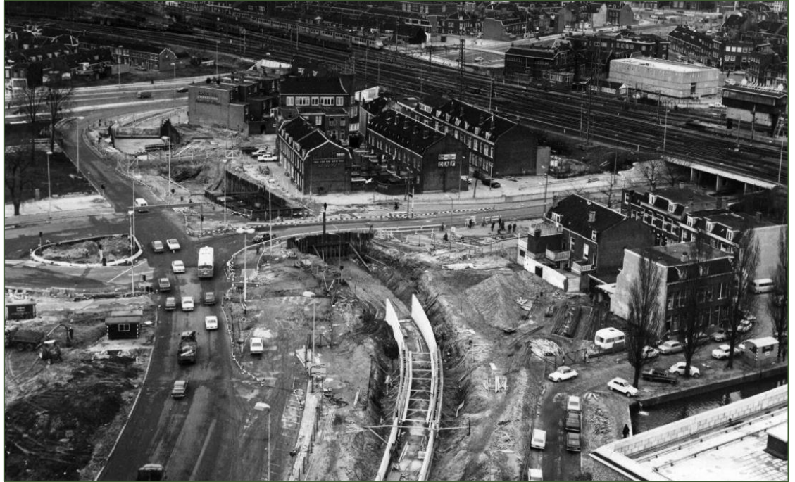
Gezicht op het in aanbouw zijnde Westplein in 1970. 49
