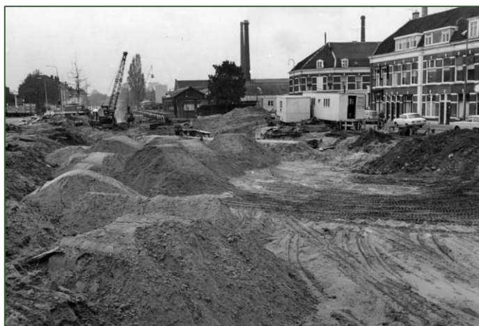
Gezicht op het dempen van een deel van de Leidsche Rijn t.b.v. de aanleg van het Westplein in 1968. 45
