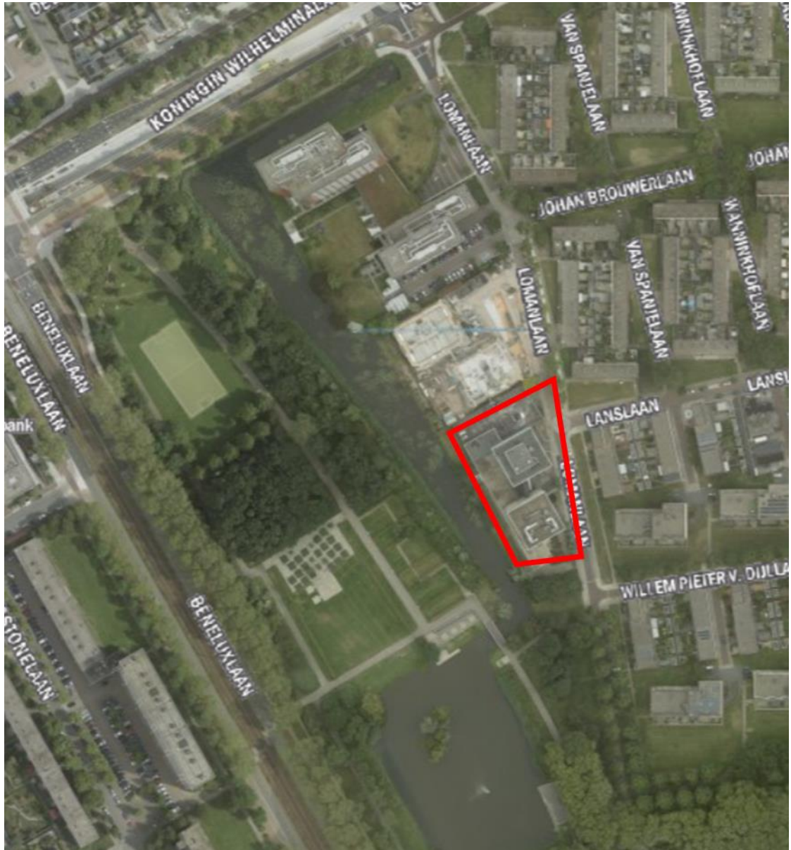
Figuur 2-1: Locatie plangebied (bron: Luchtfoto NL 2018 © CycloMedia Technology B.V.)
