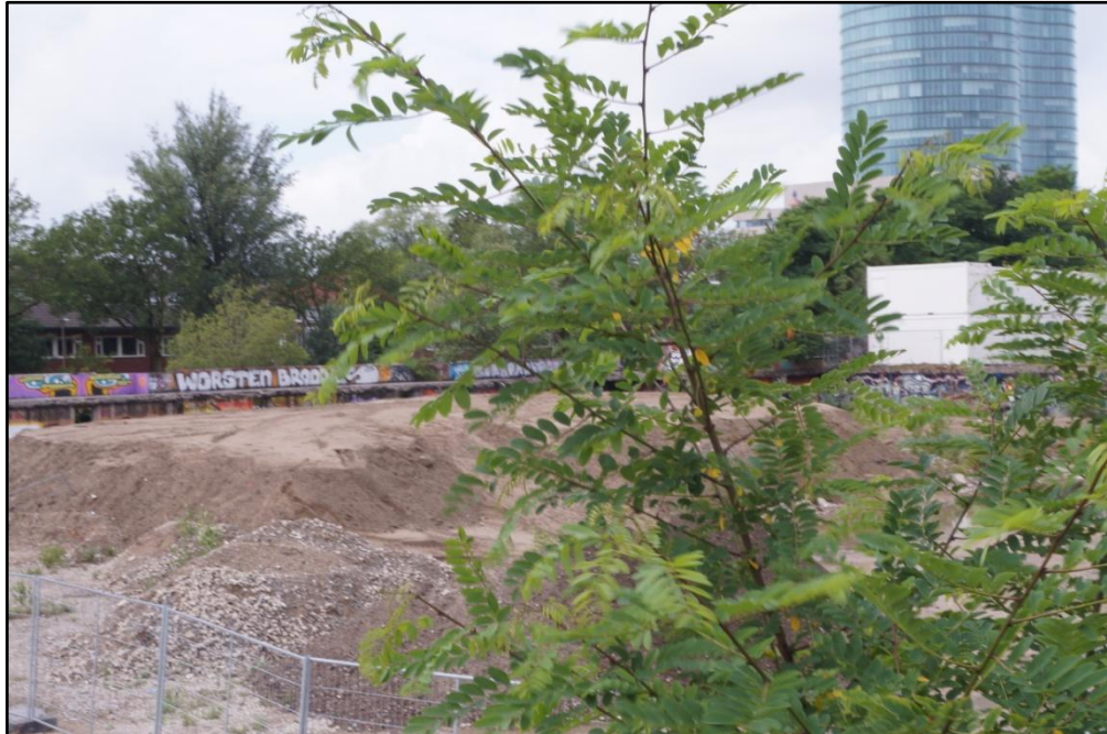
Figuur 20. Zanddepot in het noordelijk gedeelte van het voormalig postsorteercentrum.
