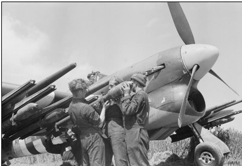
Figuur 23. Een foto uit 1944 waarop te zien is hoe grondpersoneel een Hawker Typhoon bewapend met 3 inch raketten met gevechtslading SAP-HE van 60 lb. (Bron: Imperial War Museum, foto CL 157.)
