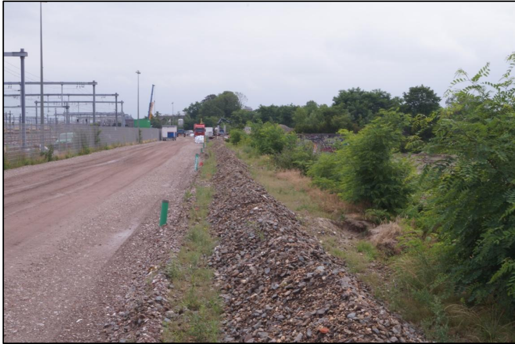
Figuur 17. Langs het spoor is een weg in aanleg.
