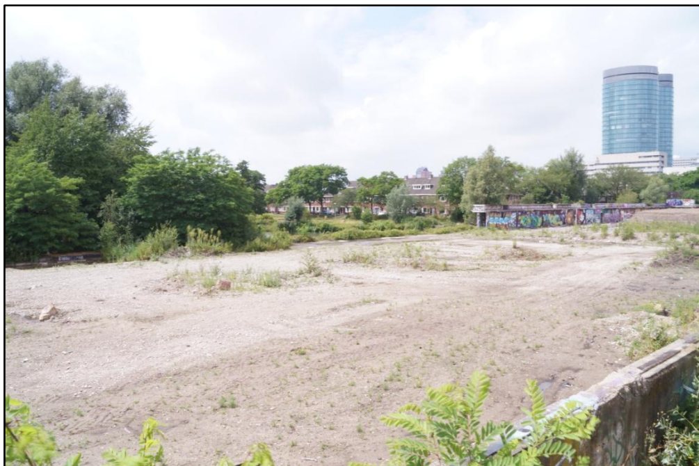
Figuur 19. Het voormalig postsorteercentrum gezien in noordwestelijke richting. Op de keldervloer is grond vermengd met puin aangebracht.
