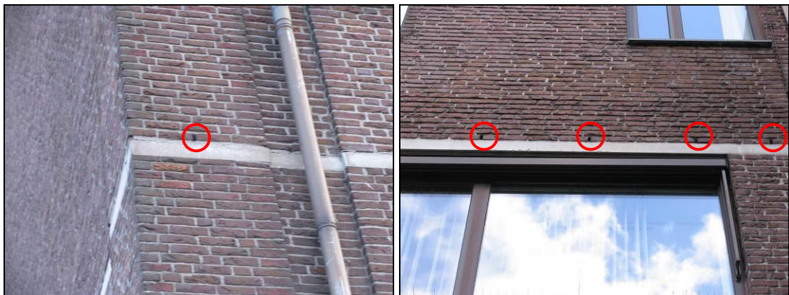
Open stootvoegen (rood omcirkeld) in de gevel van het pand geven mogelijk toegang tot de spouwmuur waarin vleermuizen een verblijfplaats kunnen hebben. Foto's SAB (2014).
