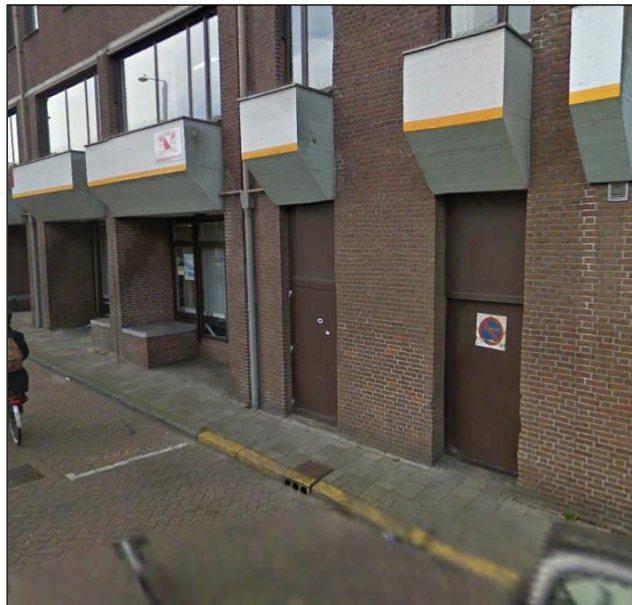
Figuur 2: Luifels of pui uitbouwen ter hoogte van de laad en loslocatie.
