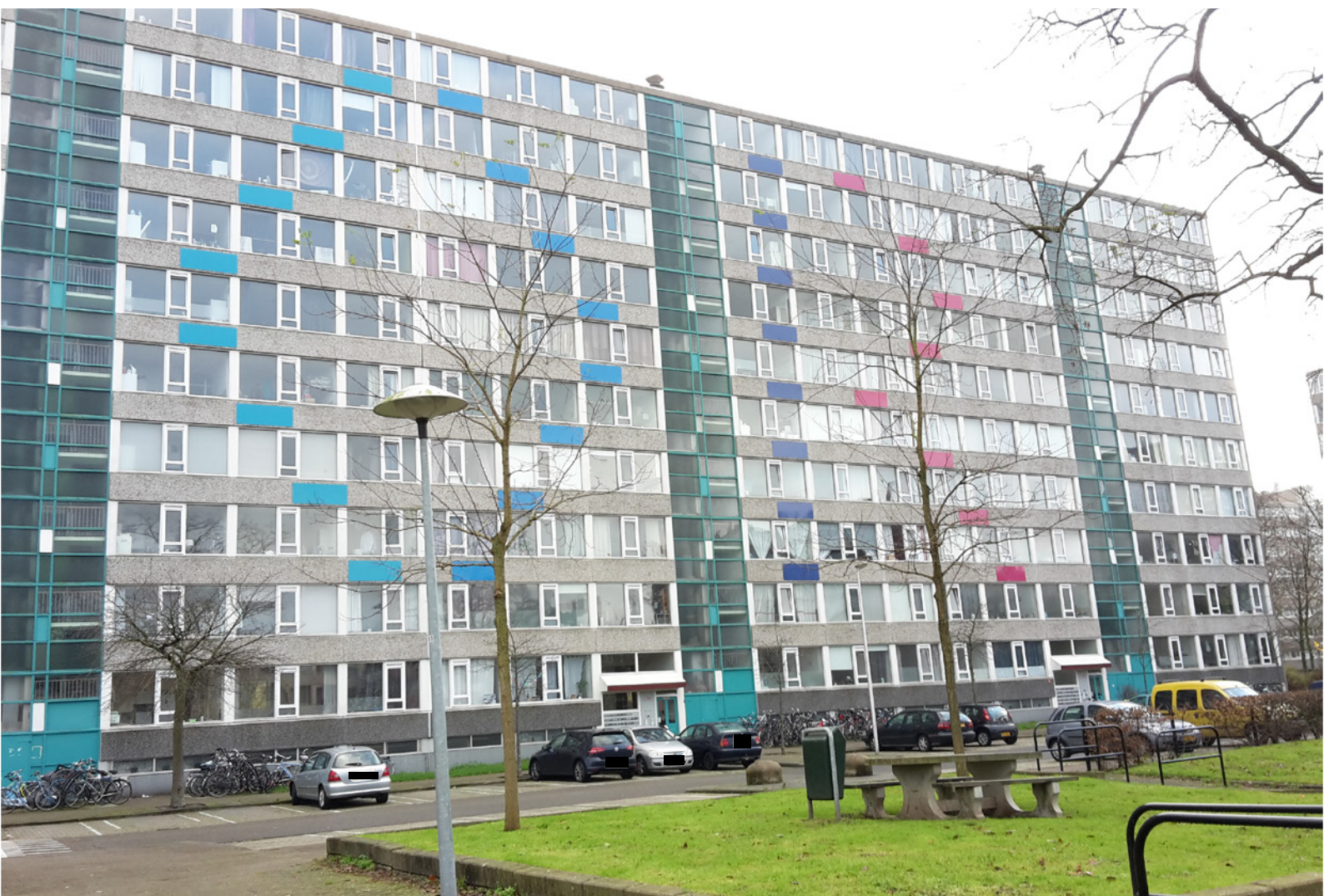
De noordwestzijde van het te slopen pand
