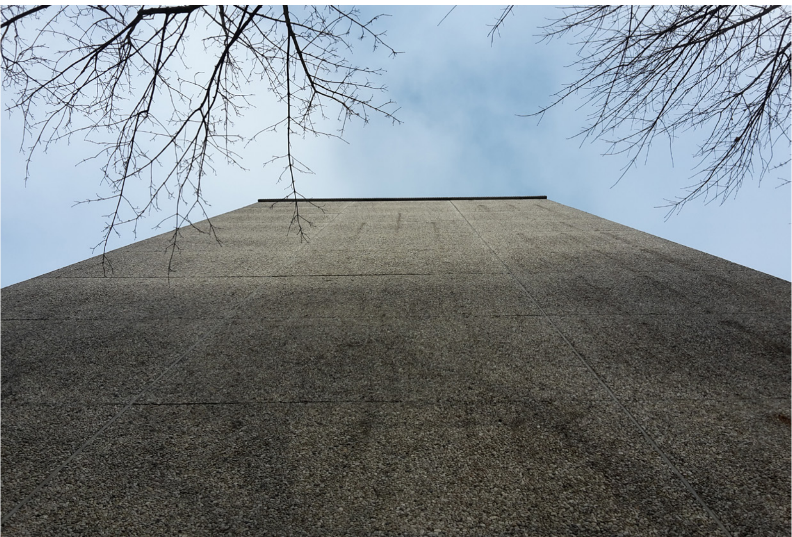
Een kopgevel van het te slopen pand
