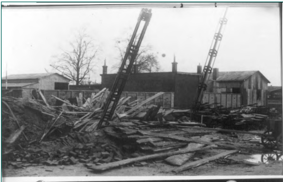
Figuur 13: Kraters en schade bij de houtopslag.
