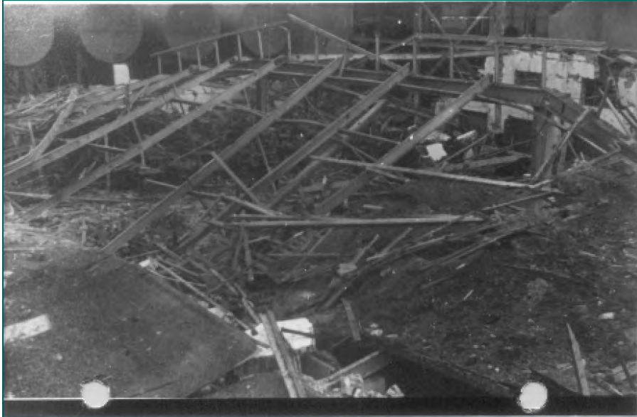
Figuur 10: De verwoeste constructiewerkplaats.
