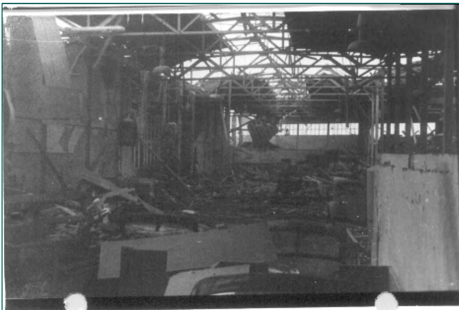
Figuur 11: Schade aan de assemblagehal.
