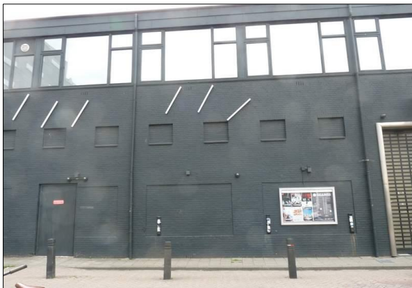
Figuur 11. Zuidoost muur van het aangrenzende gebouw van het poppodium.
