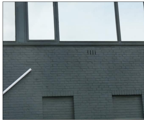
Figuur 12. Detail van de ventilatieopeningen in het aangrenzende gebouw van het poppodium.
