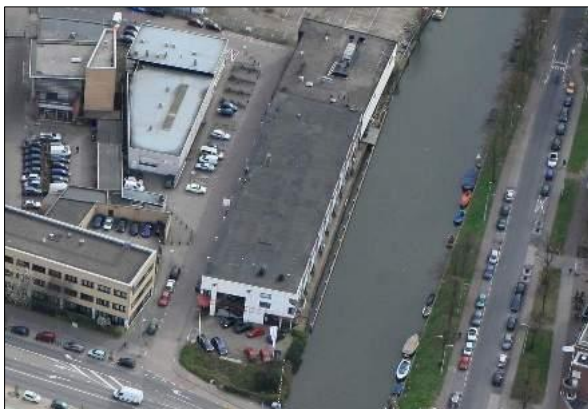
Figuur 3. Plangebied, gezien vanuit de lucht, waarop beide gebouwen te zien zijn. Het gebouw met het langwerkpige dak wordt gesloopt, het gebouw met het vierkante dak blijft staan.
