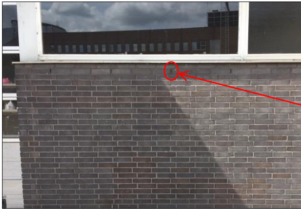
Figuur 9. Open stootvoegen aanwezig op circa 1.80 m hoog.
