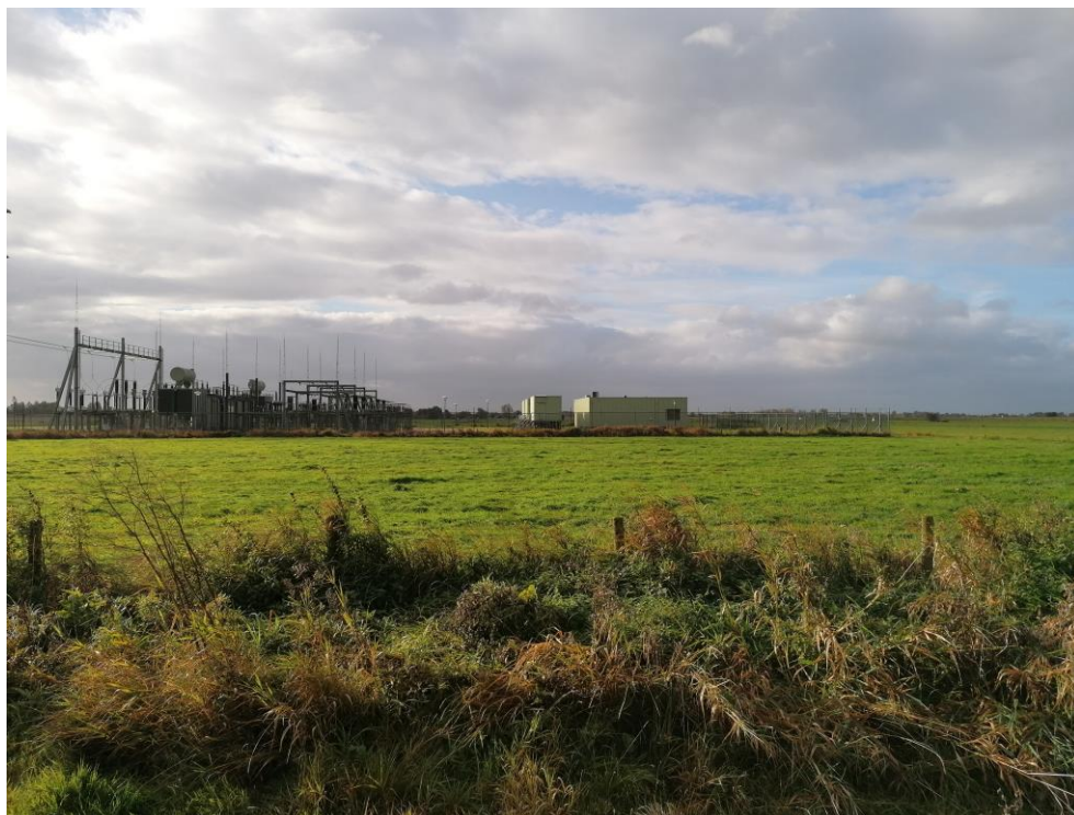
Figuur 1.4: Agrarisch perceel grenzen aan de noordkant van het huidige hoogspanningsstation (bezoek 22 oktober 2021).
