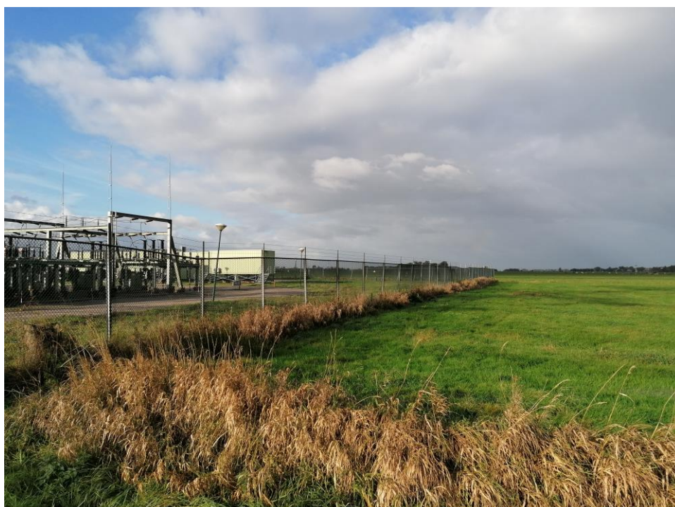
Figuur 1.2: Bestaande hoogspanningsstation waar in de hoek achter het hek de gebouwen voor de 10- en 50kV installaties dienen te komen (bezoek 22 oktober 2021).
